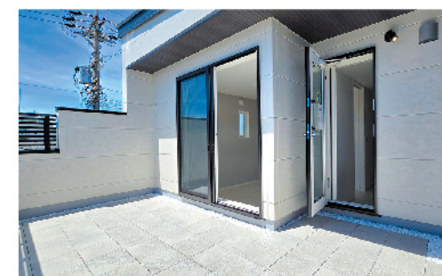
屋上庭園「そら」
